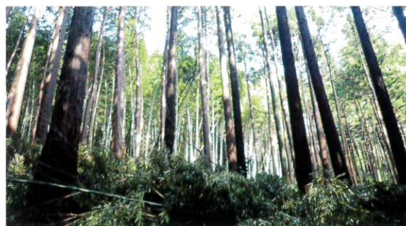
侵入竹伐採 施工後
